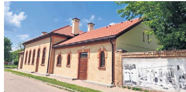
W trakcie prac została oczyszczona m.in. ceglana fasada
