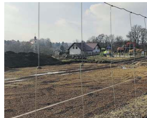
Budowa kompleksu rekreacyjnego w Porębie Żegoty
