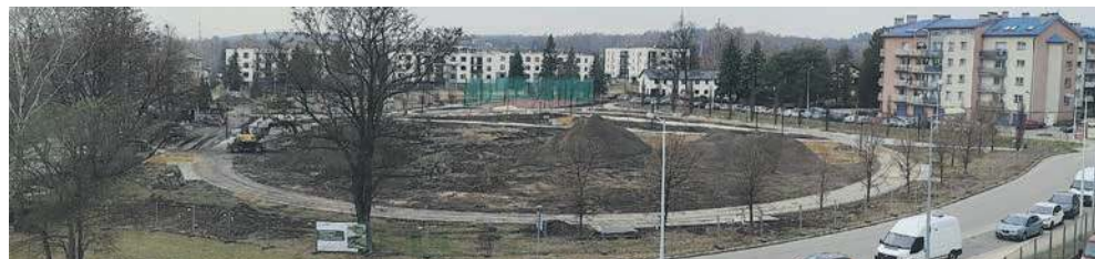
Chrzanowskie Błonia w budowie
