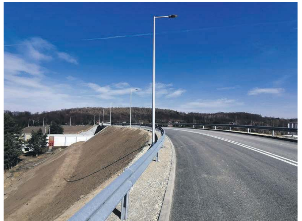
Nowy wiadukt nad torami w Młoszowej
