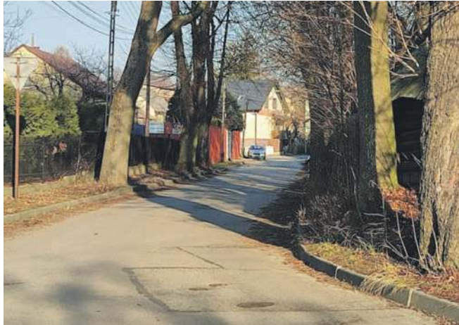
(zew) Będzie remontowana m.in. Starowiejska w Trzebini
