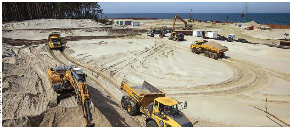
Budowa kanału na Mierzei Wiślanej ma zakończyć się w 2022 r.
