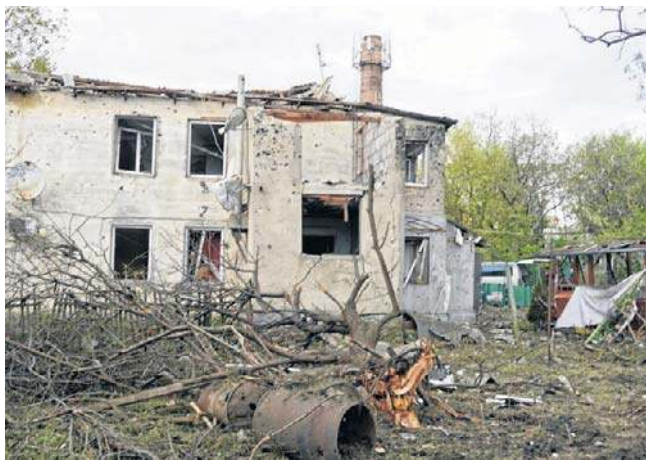
Zniszczenia po niedawnym ataku rakietowym wojsk rosyjskich na dzielnicę mieszkalną w Odessie
