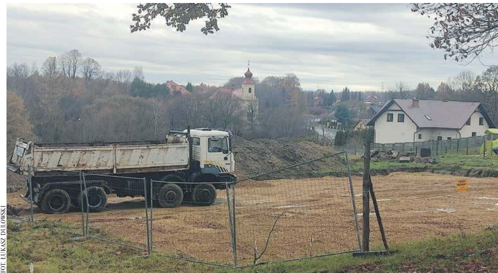
Budowa kompleksu sportowo-rekreacyjnego w Porębie Żegoty
