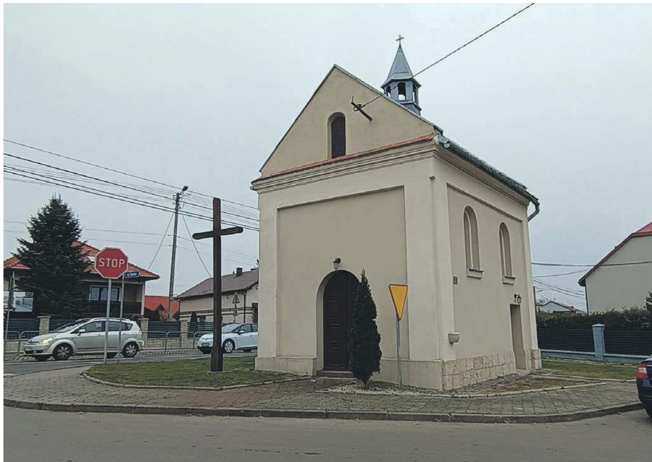
Zabytkowa kaplica w centrum Żarek, wyłączona z użytku sakralnego, jest już wyremontowana. Na razie nie wiadomo, na jaki cel zostanie przeznaczona
