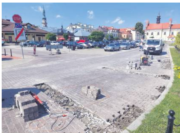
Prace przy ul. Łukasieńskiego w Zamościu potrwać do końca wakacji.
