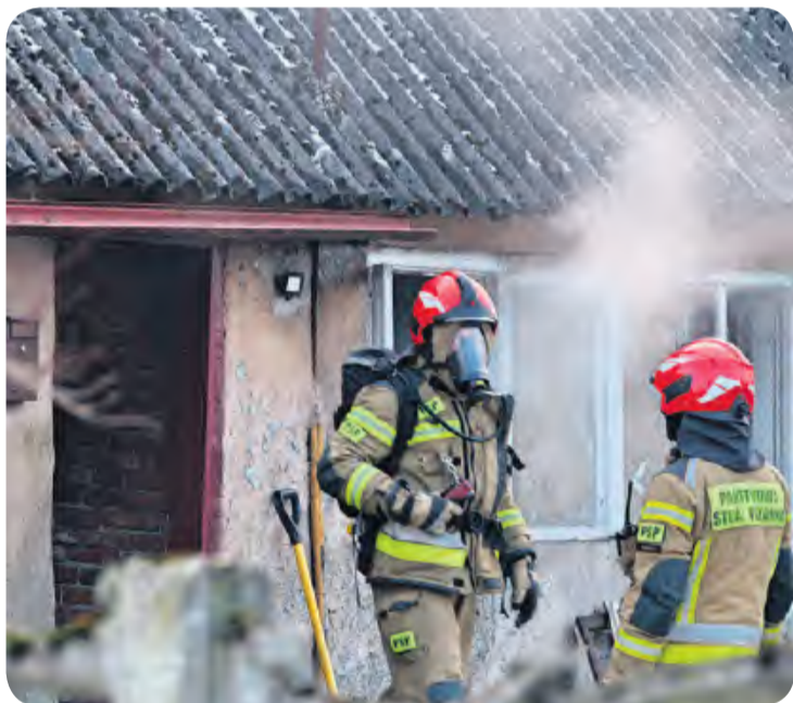
Pożar rozwinął się wewnątrz starego domu. W środku zawalił się strop.
