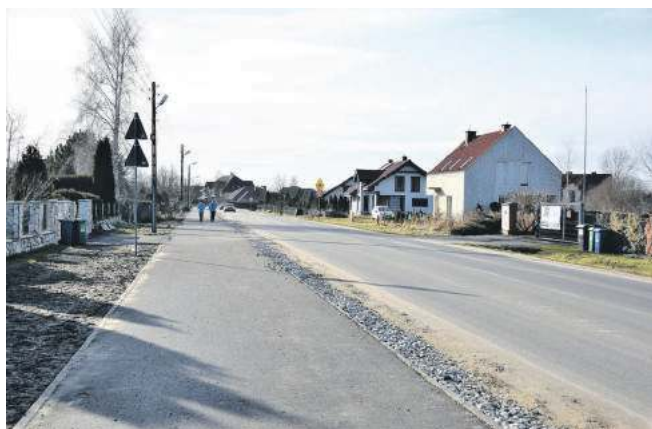
W Szewcach został odebrany ok. 1 km ciągu pieszo-rowerowego wzdłuż ulicy Długiej
