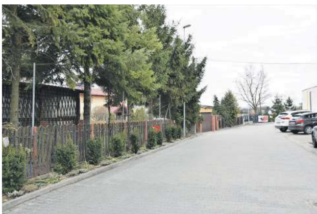
W Psarach dobiegła końca budowa sięgacza ulicy Głównej
