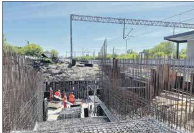
Cały czas trwają prace przy budowie peronu w Białej Podlaskiej. Na zdjęciu montaż zbrojenia przejścia podziemnego na stacji
