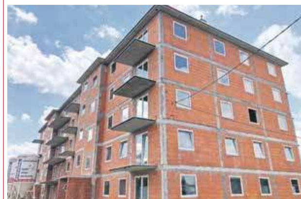
Budowa przy ulicy Kąpielowej 2a
