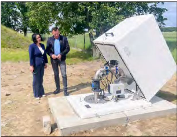
⚡ Na stacji uzdatniania wody w Nowym Goniwilku wykonano nowy odwiert studni głębinowej. 12 czerwca dokonano odbioru końcowego realizacji inwestycji „Przebudowa stacji uzdatniania wody na terenie gminy Żelechów” od razu podłączona do istniejących urządzeń stacji. Dodatkowo, aby zapew-
