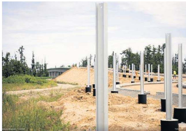
Zaawansowanie prac wynosi 80 proc. Mosty i estakady są już wykonane, trwają prace wykończeniowe oraz związane z ochroną środowiska, np. montaż ekranów
