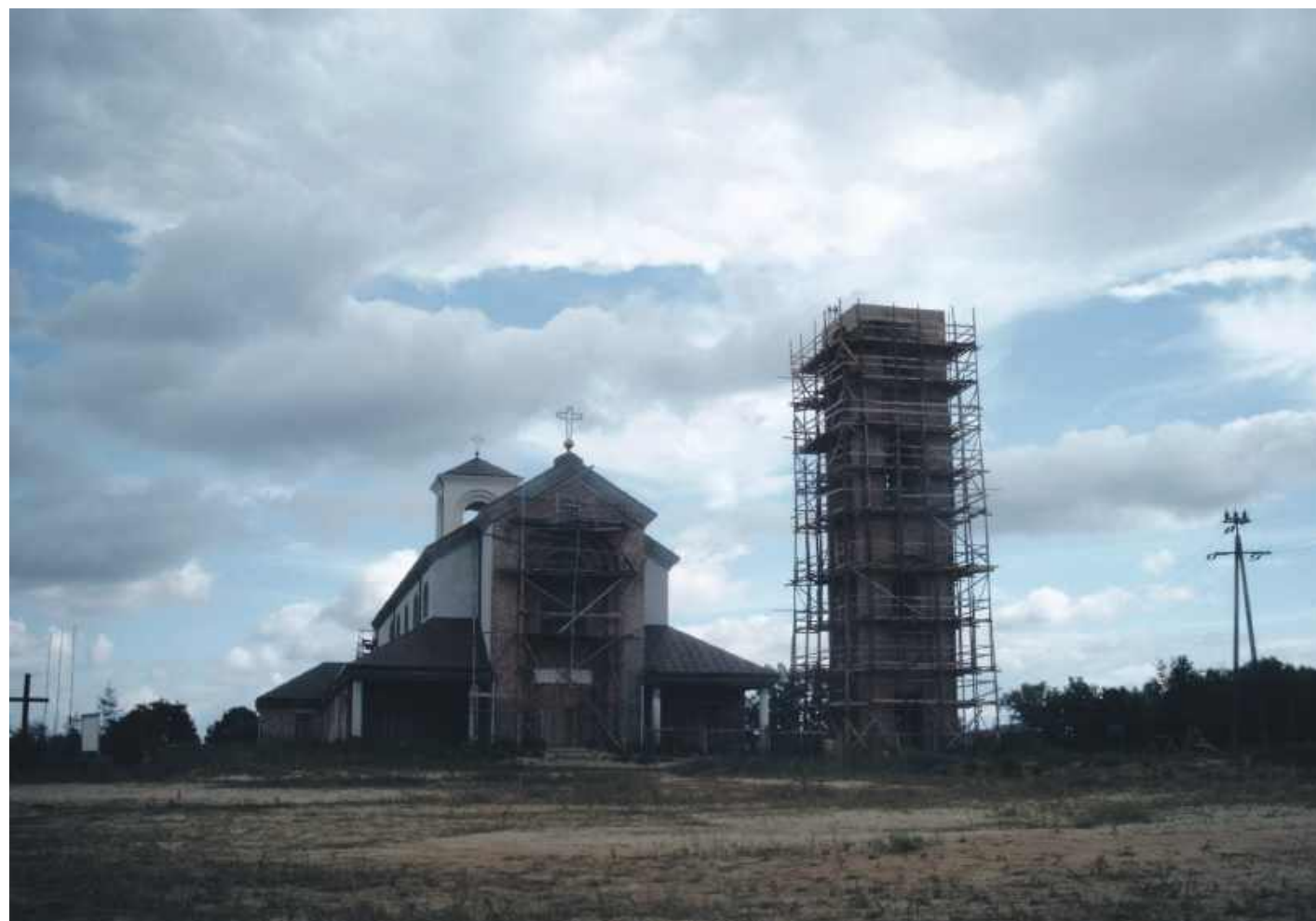
Budowa kościoła na Popławach w 2003 r.
