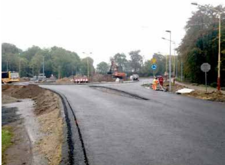
W ostatnich latach w Stargardzie prowadzono było mnóstwo inwestycji drogowych
