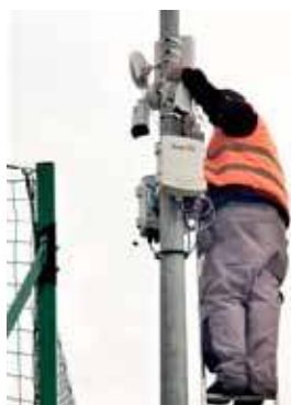
Trwa montaż kamer na Osiedlu Pyrzyckim. Inwestycja realizowana jest w ramach Stargardzkiego Budżetu Obywatelskiego
