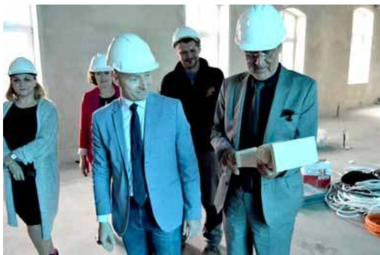
Prezydent Rafał Zając przyjrzał się postępowi prac przy budowie Stargardzkiego Centrum Nauki
