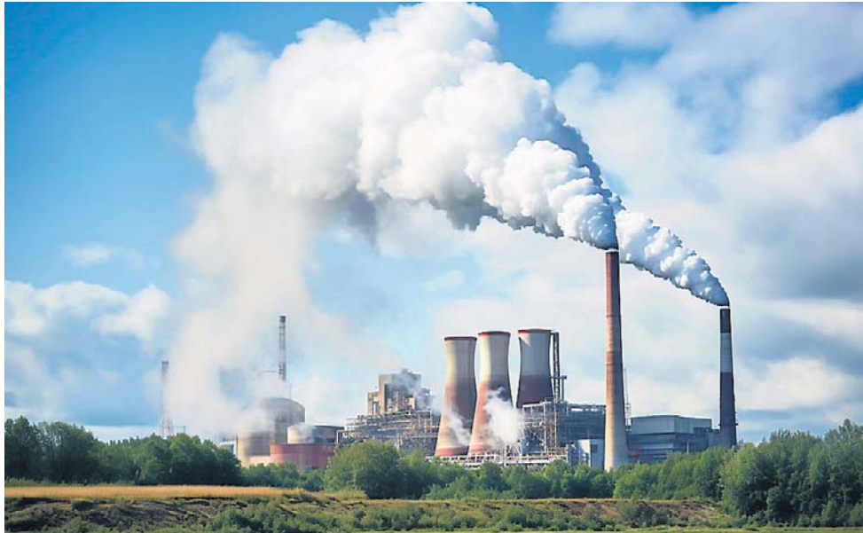
System ciepłowniczy w Polsce wymaga ogromnych nakładów inwestycyjnych
