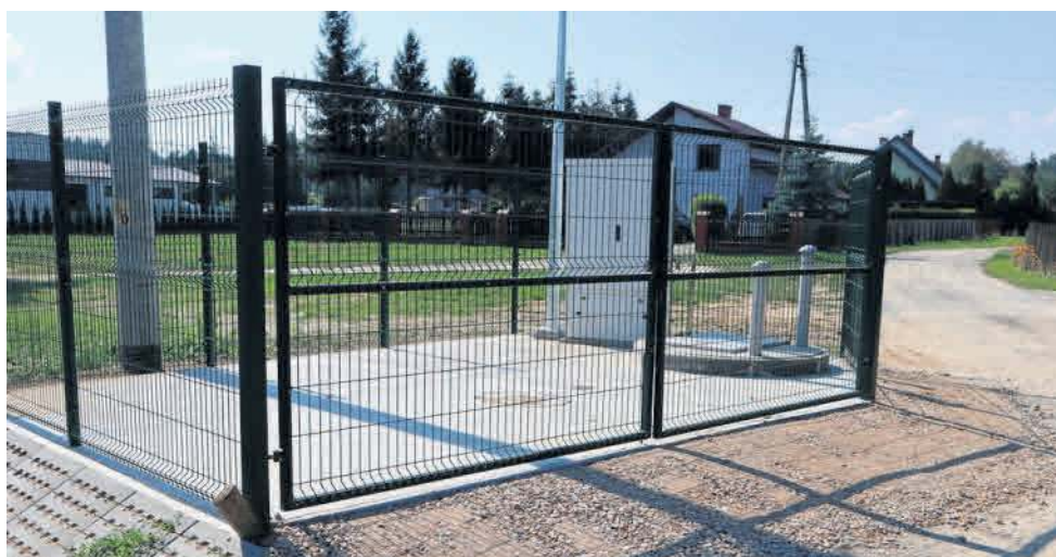
W ramach inwestycji wybudowano sieć kanalizacyjną o łącznej długości ponad 20 kilometrów, a także sześć przepompowni ścieków i 198 przyłączy o długości prawie 3,8 km
