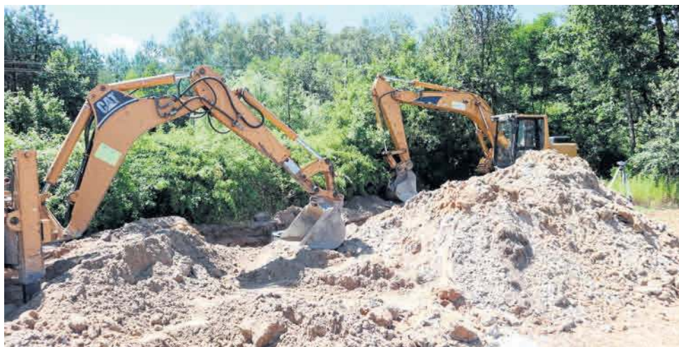
Budowa sieci kanalizacyjnej w Pogórskiej Woli rozpoczęła się pod koniec listopada 2018 roku. Prace trwały do jesieni tego roku. Ich wykonawcą była lokalna firma MAT-MAT
