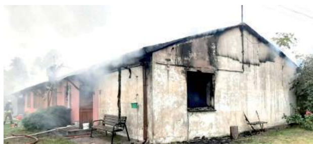
Strażacy zdjęli z dachu kilka arkuszy blachy. Poprzez powstałe otwory gaszono palącą się konstrukcję domu i oddymiano wnętrze
