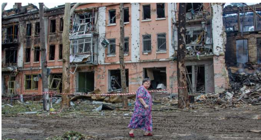
Зруйнований будинок в Миколаєві, в якому я колись жила. Фото – Никвести
