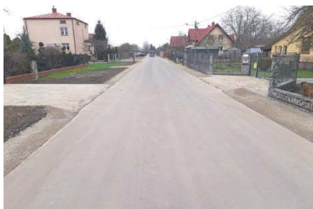
Od teraz mieszkańcy Matyg mogą korzystać z wyremontowanej drogi
