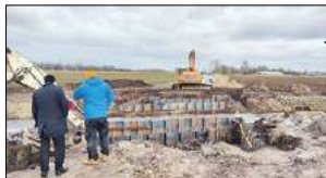
Władze powiatu i zarządu dróg powiatowych skontrolowały postęp prac przy przebudowie mostu w Lisiwólce
