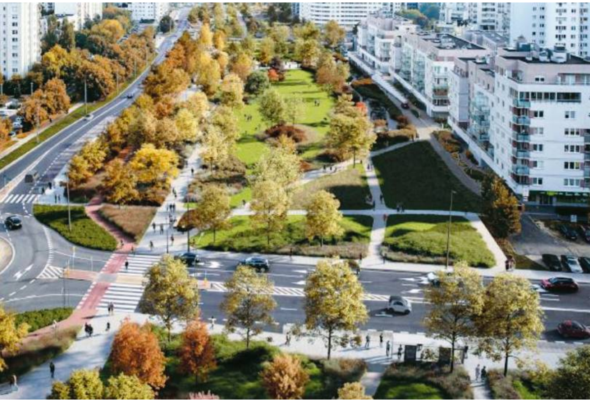
Pierwsze prace – na odcinku od ul. Stryjeńskich do al. KEN – mają rozpocząć się w tym roku | fot. Palmett/d
