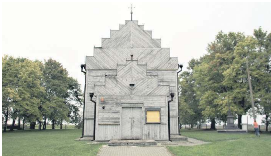
Front świątyni wygląda bardzo nietypowo. Tak czasami budowano murowane kościoły neogotyckie. Przeniesienie takiego rozwiązania do architektury drewnianej dało bardzo ciekawy efekt.
