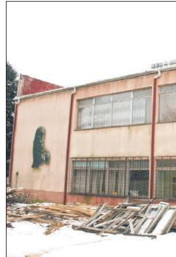
Elewację Morsa czeka przebudowa.
