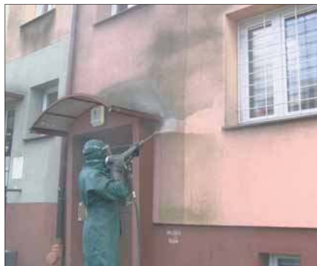
Większe zabrudzenia usuwane są z użyciem myjki ciśnieniowej
