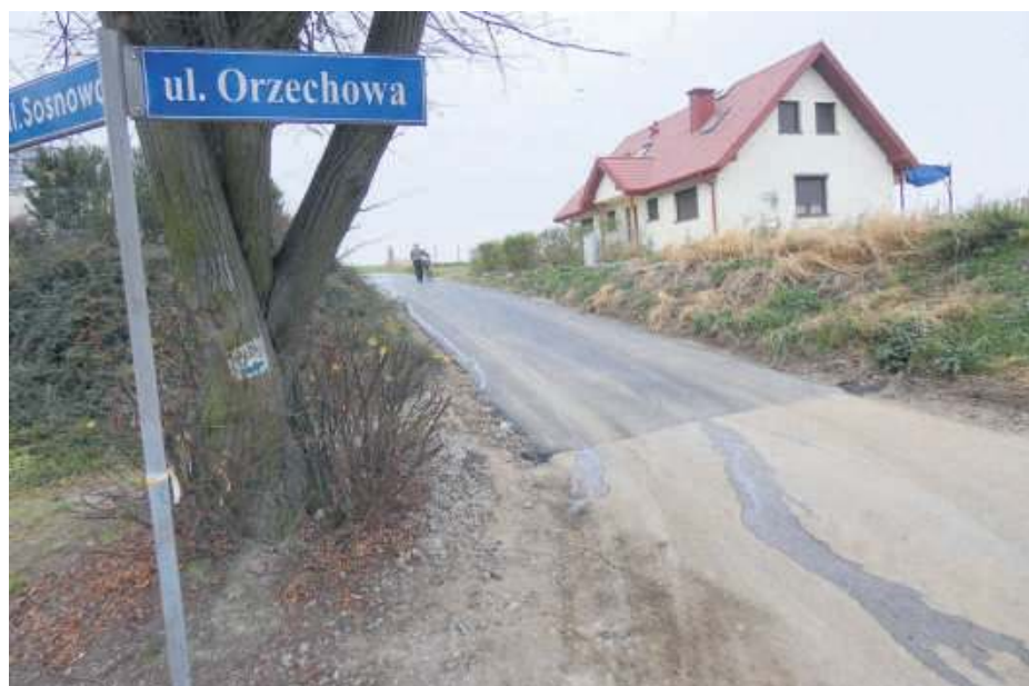
W ubiegłym tygodniu dywanik asfaltowy położono na ul. Orzechowej w Gęsińcu (przyległej do ul. Sosnowej)
