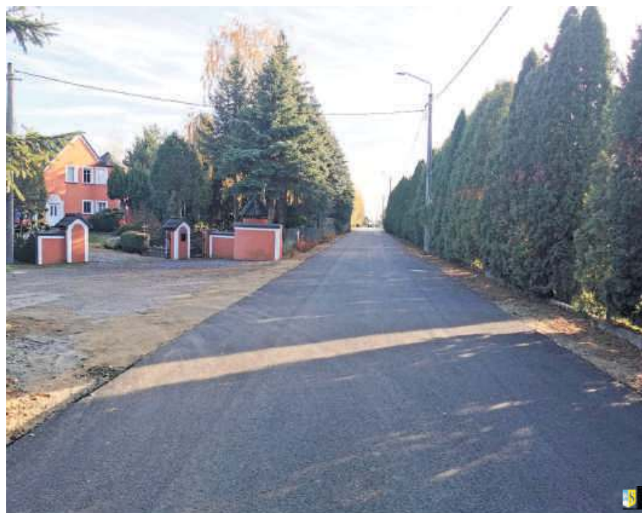
Ulica Klonowa w Pławnej, to kolejna gminna droga, która w ostatnich tygodniach otrzymała zupełnie nową nawierzchnię
