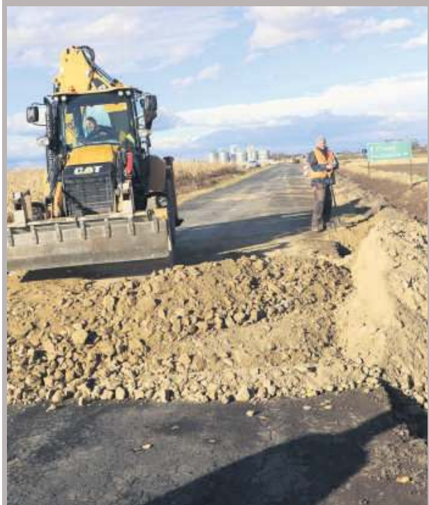
Na odcinku Wiązów-Jędrzychowice trwa właśnie remont nawierzchni. Foto: Facebook Wiązów
