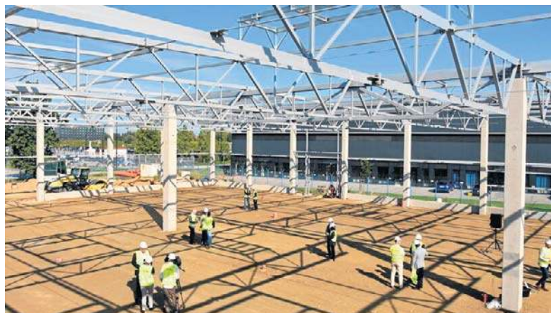
Nowa hala umożliwi rozwój usług towarowych
