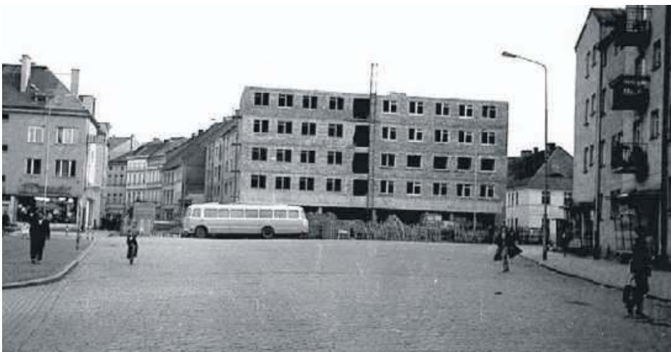
To samo miejsce patrząc w drugą stronę, też 1965 rok. Budynek w budowie na skrzyżowaniu ul. Brzeskiej i Ryńku, tu na parterze powstanie sklep meblowy
