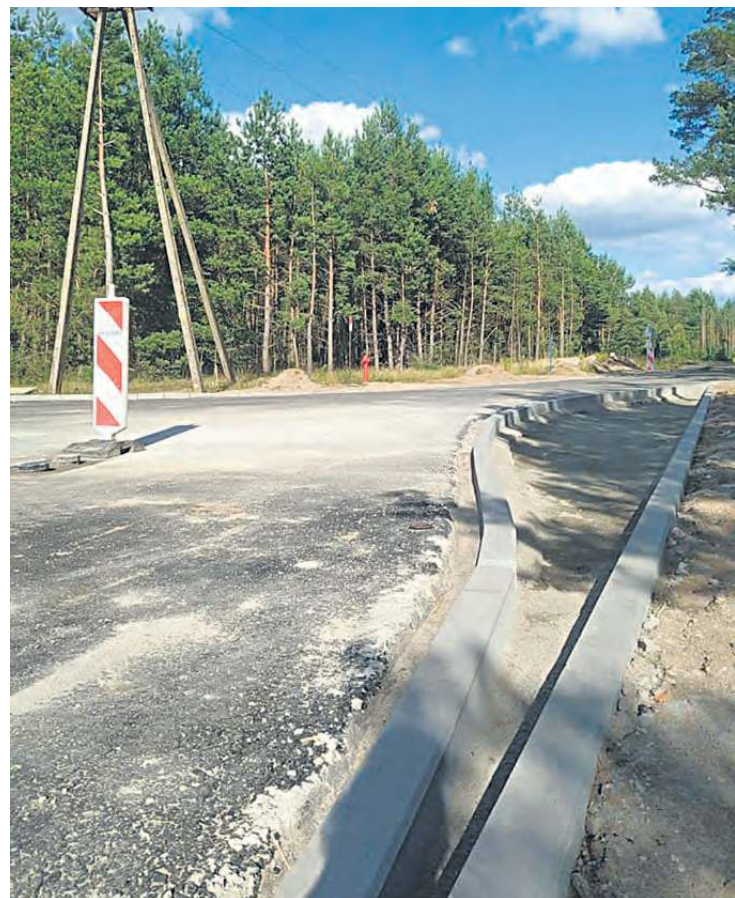
Jeszcze prace wykończeniowe i odbiory.
