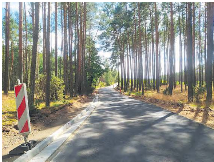
Fragment nowej drogi.
