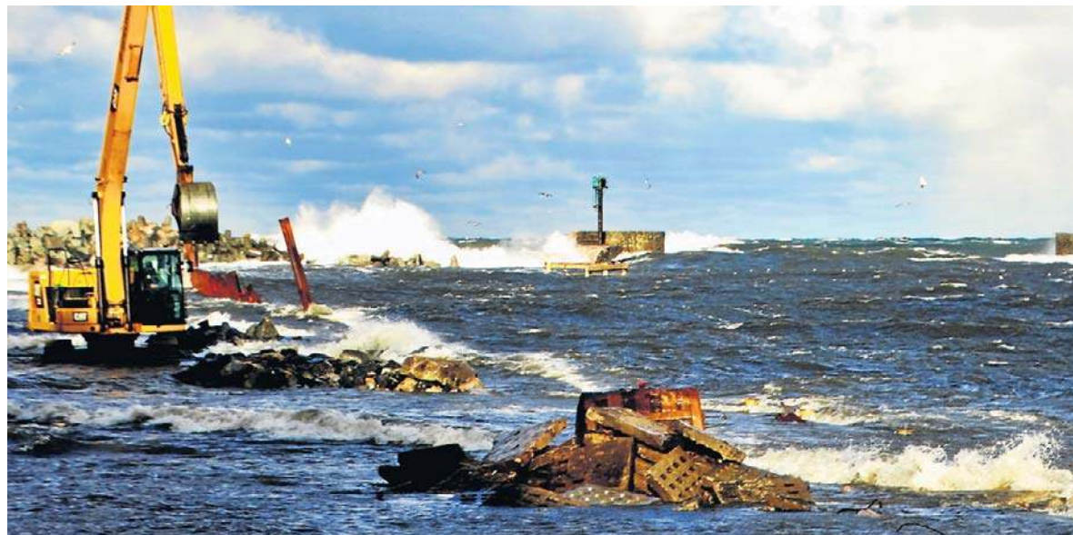
Prace przy rozbiórce Falochronu Zachodniego w porcie w Ustce
