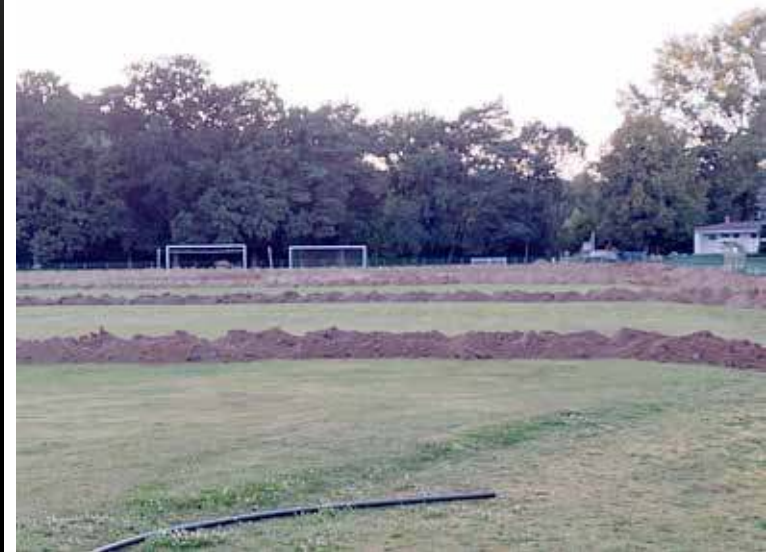
Boisko w remoncie. Instalowany jest m.in. system nawadniania
