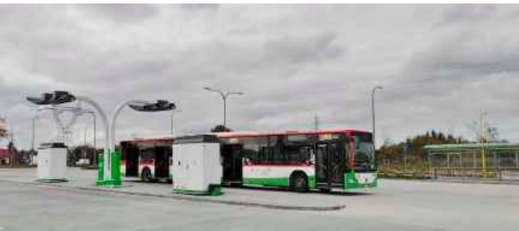
Nowa pętla autobusowa na ul. Żeglarskiej
