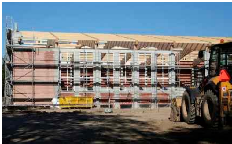
Na budynku hali stanęła już więźba dachowa. Od września przyszłego roku 700 uczniów Staszica będzie miało do dyspozycji pełnowymiarową salę gimnastyczną (ok. 45 na 50 metrów) z podpiwniczeniem i trybunami na 256 osób. Obok niej powstanie kompleks boisk z bieżnią i skocznią
