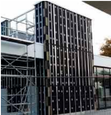
PKP zapewnia, że nowy dworzec zostanie oddany do użytku jeszcze w tym roku
