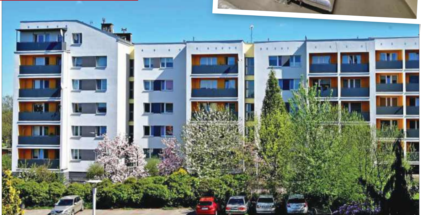
Budynek mieszkalny przy ulicy Orkana po przeprowadzonej termomodernizacji.
