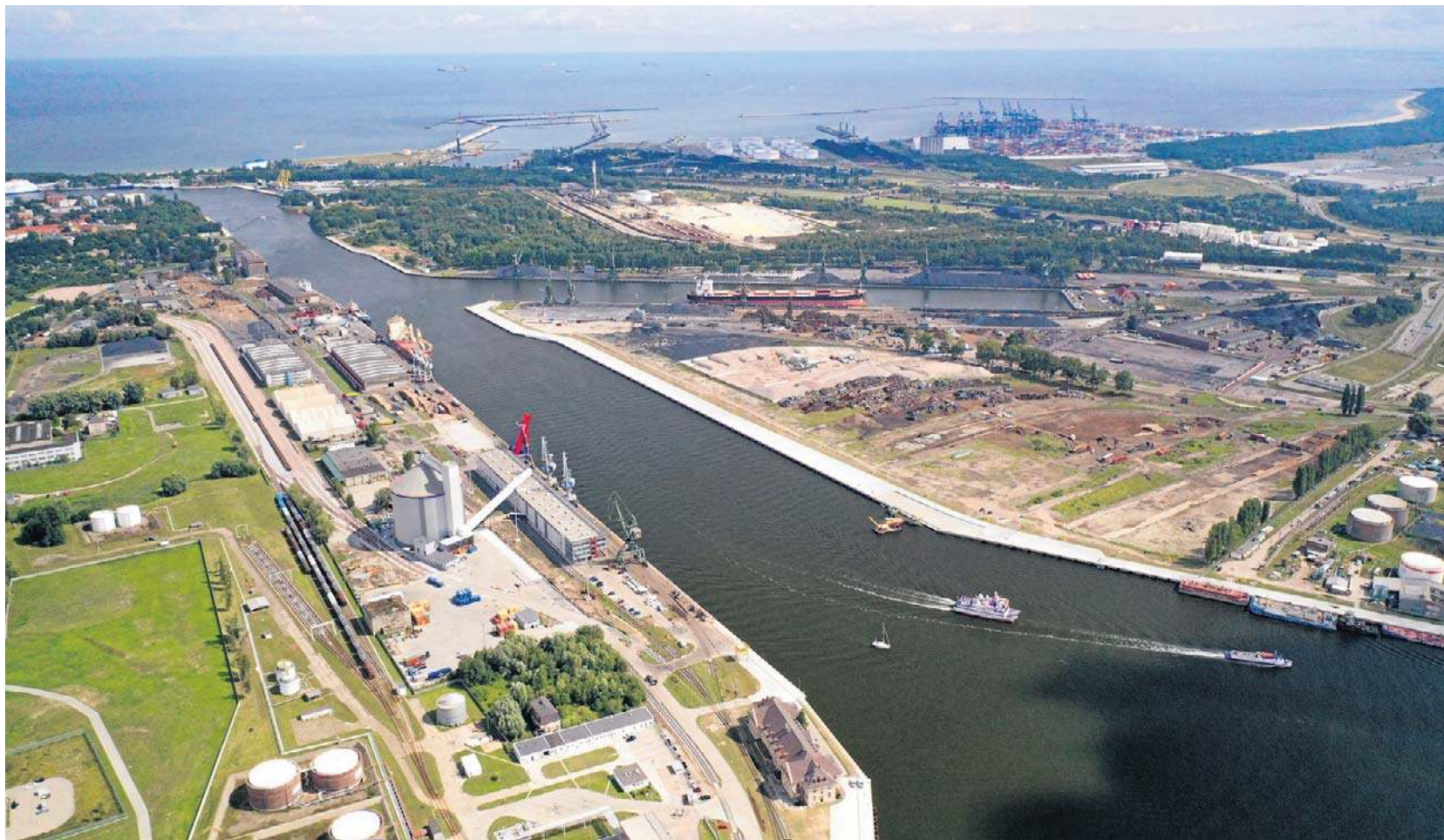
Port Wewnętrzny w Gdańsku dzięki modernizacji toru wodnego i nabrzeży może przyjmować większe statki
