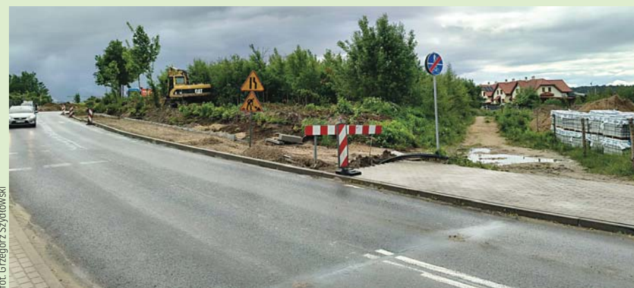
Budowa ścieżki rowerowej z Zacisza do Bartąga
