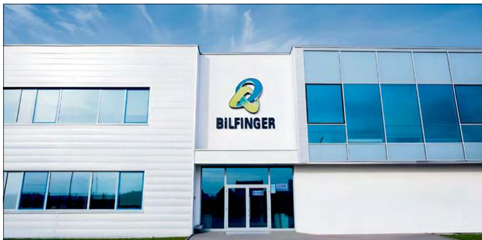
Siedziba firmy w Krapkowicach.
