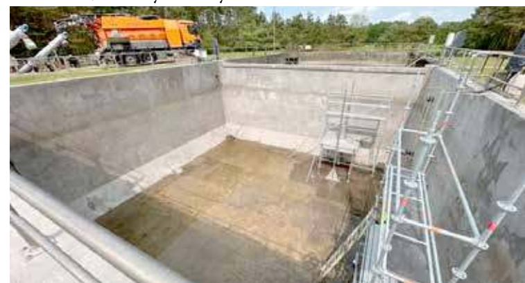
Remont oczyszczalni trwa
