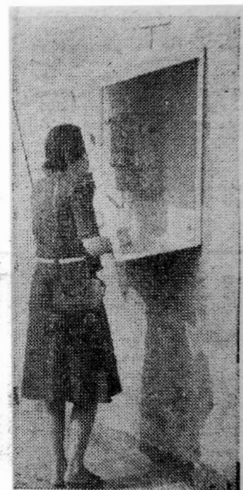
Zamiast tradycyjnej budki telefonicznej – automat telefoniczny umieszczony pod chroniącym od deszczu daszkiem.
