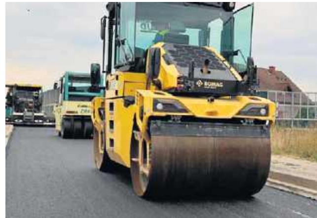
Ruszyło układanie warstw asfaltu na pierwszym odcinku remontowanej obwodnicy zachodniej Nowego Sącza
