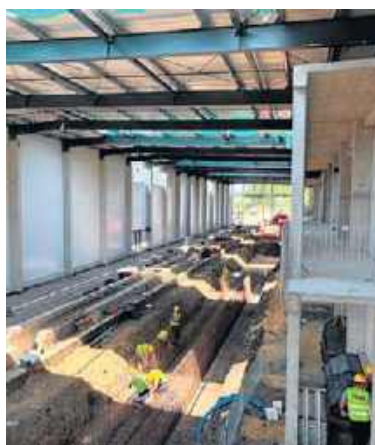
Budowa centrum serwisowego, postępuje bardzo szybko
