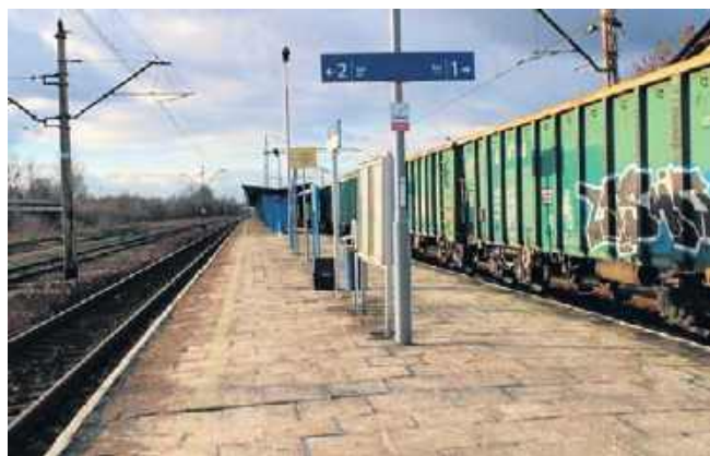
Tak wyglądała stacja w Olkuszu przed modernizacją. Przebudowa kosztowała około 110 milionów złotych
