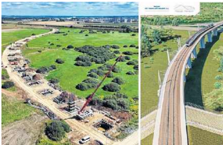
Tak powstaje nowa estakada kolejowa pod Krakowem
