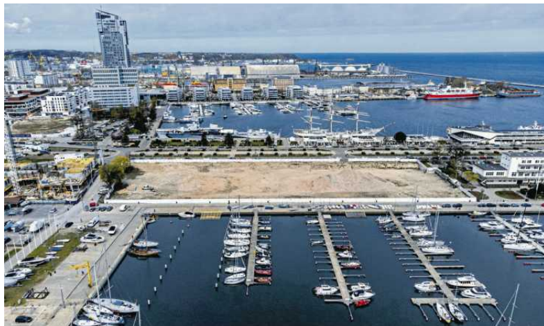
• W miejscu wyburzonych budynków klubów żeglarskich powstać mają nowoczesne obiekty Nowej Mariny FOT. MICHAŁ RYŃIAK / AGENCJA WYBORCZA.PL
