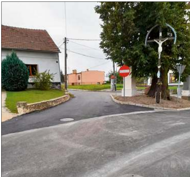
Asfalt położono również tam, gdzie pierwotnie tego nie planowano.
