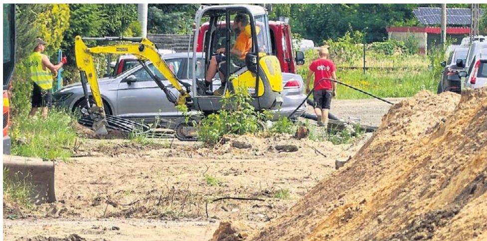
Taki był stan przebudowy ulicy Olsztyńskiej we wtorek 23 czerwca
