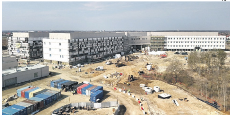
Budowa Nowego Szpitala Onkologicznego idzie pełną parą
