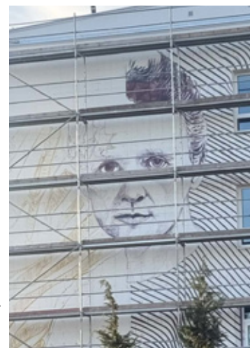
Praca nad obecnym murem trwa.
