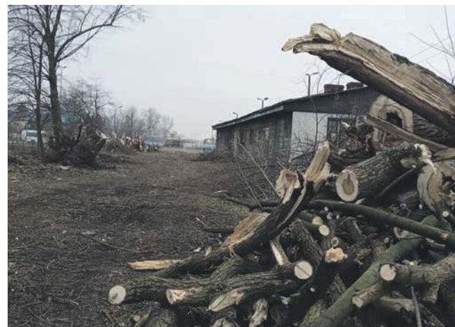
Roboty zaczęły się od porządkowania terenu i wycinki drzew
