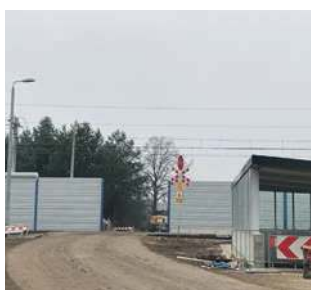
W rejonie ulicy Trzebiej w Młoszowej powstanie podziemne przejście kolejowe dla pieszych
