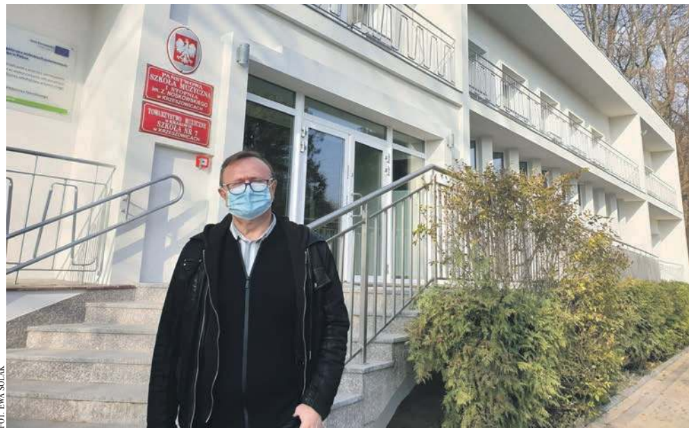
Jerzy Surulo, dyrektor Państwowej Szkoły Muzycznej w Krzeszowicach, przed wyremontowanym budynkiem
