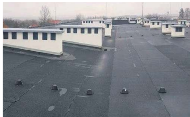
Dach Urzędu Miejskiego w Alwerni po remoncie
