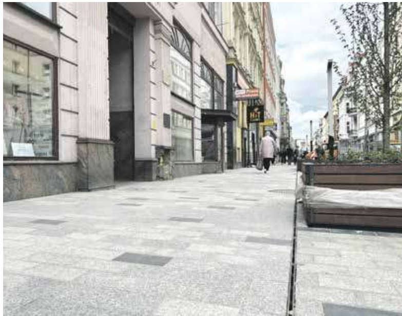
Nawierzchnia z ciętego kamienia to jedna z wizytówek nowej Dworcowej
