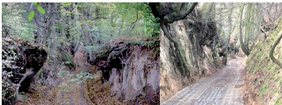
Takie porównanie stanu przed i po robotach drogowych w wąwozie prezentują organizatorzy petycji na stronie internetowej „Kazimierz Dołujący”. Temat wąwozu nie jest jedynym, o jakim piszą na portalu – inne to dewastacja krajobrazu przez prywatną inwestycję w Międmierzy, Off-road na terenie Parku Krajobrazowego, wycinanie drzew czy projekt Smart City
