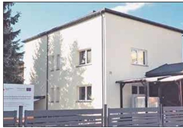
Budynek na Kolejowej jest już po remoncie. MOPS szuka rodziny, która stworzy tu rodzinny dom dziecka
