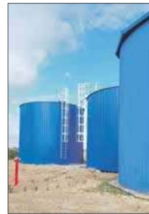
Jedną z najważniejszych inwestycji ostatnich lat w gminie Międzyrzec Podlaski była rozbudowa SUW w Rzeczy
