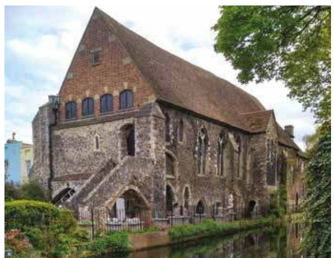
Krzemień pozyskany z klifów kredowych jest doskonałym materiałem budowlanym, Canterbury, hrabstwo Kent
