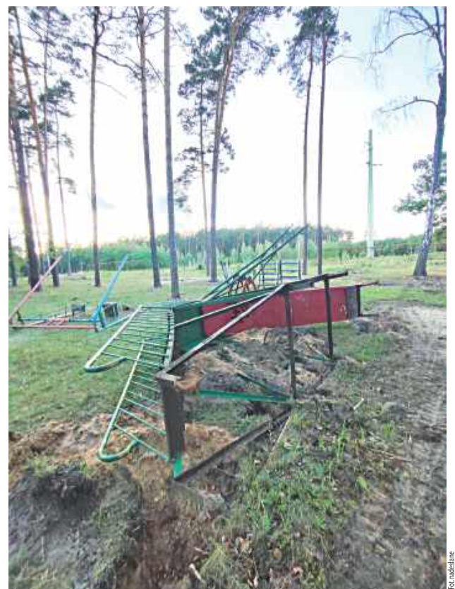
Czytelnik zwrócił uwagę na niezabezpieczone elementy
