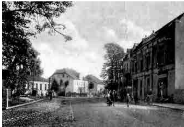
Tunel biegł pod ulicą Wawelską (kiedyś Krakauerstrasse). Fotografia z książki
