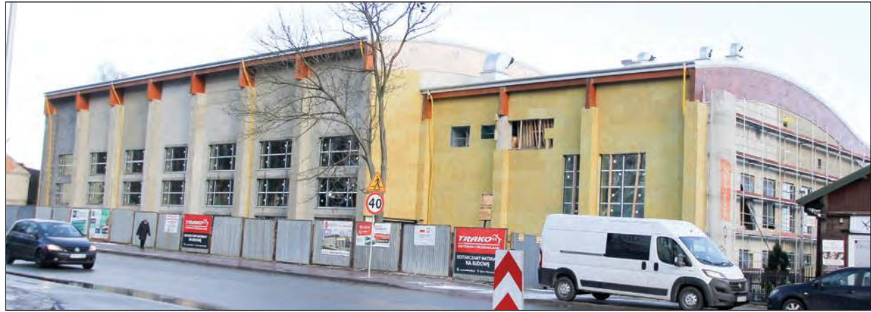
Hala sportowa przy ul. Warszawskiej jest już gotowa w 70 procentach. Obecnie główne prace trwają wewnątrz budynku
